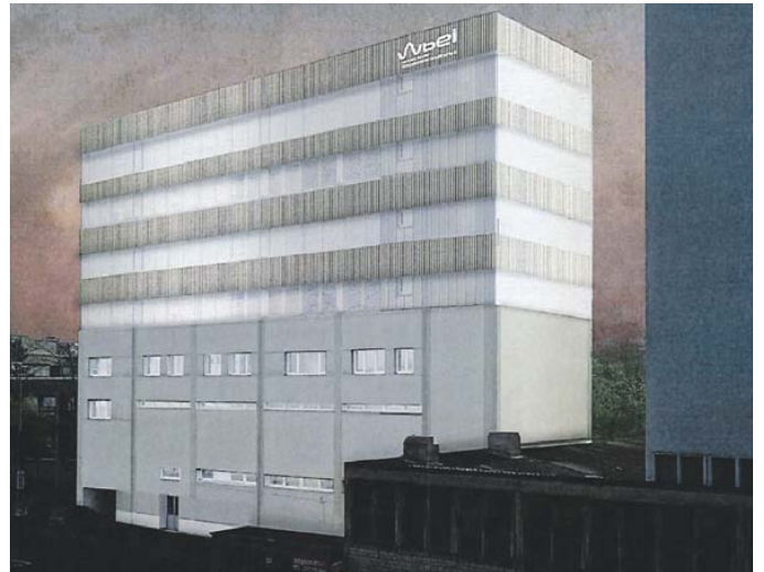
Ausbau. Der VBEI stockt sein Gebäude an der Bonergasse 22 in Kleinhüningen um zwei Etagen auf.
